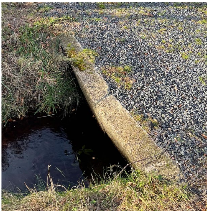
Figur 2. viser eksempler på underløb, der bør skiftes. Til venstre ses et sammenfaldet underløb (pga. tung trafik/ kørsel for tæt på kanten) og til højre et udløbsrør, der er tilstoppet ved udløbet pga. sand.
