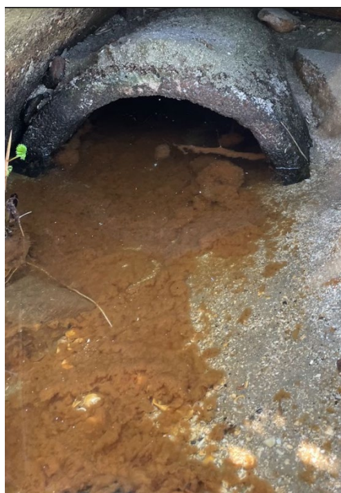
Figur 2. viser eksempler på underløb, der bør skiftes. Til venstre ses et sammenfaldet underløb (pga. tung trafik/ kørsel for tæt på kanten) og til højre et udløbsrør, der er tilstoppet ved udløbet pga. sand.
