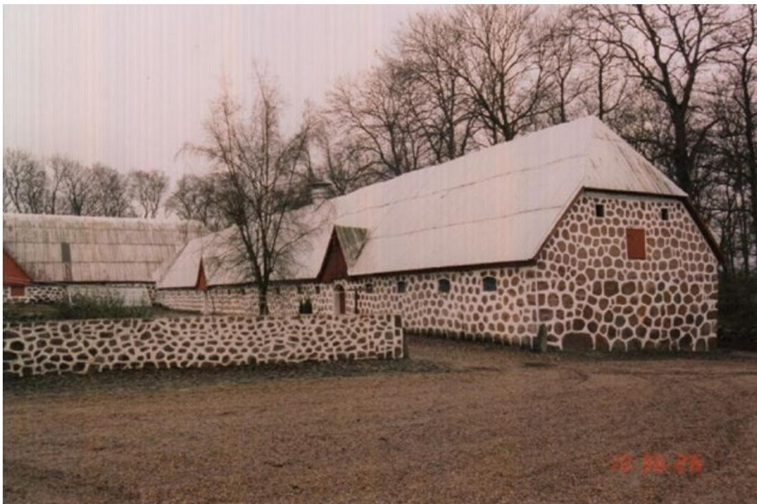
Her ses den trelænget gård med mur og halvmur af kløvede marksten med hvidkalkede fuger, optaget 1997.
