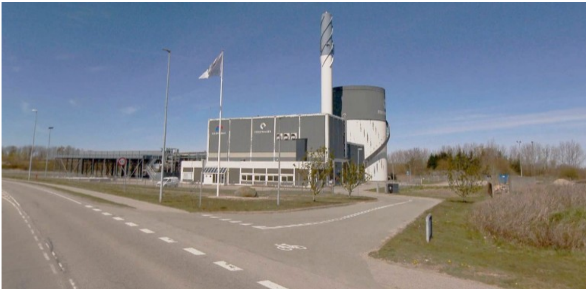
Figur 1: Frederikshavn Forsynings varmeværk set ved indkørsel fra Vendsysselvej (COWI Gedefotos).
