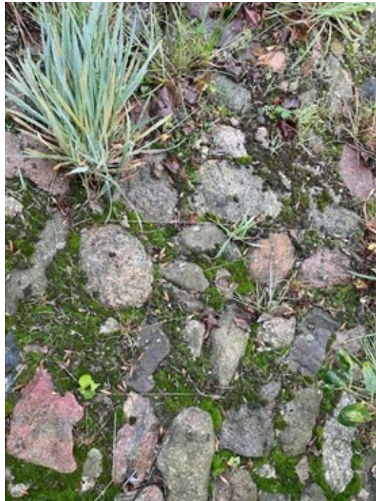
Her ses pigstensbelægningen
