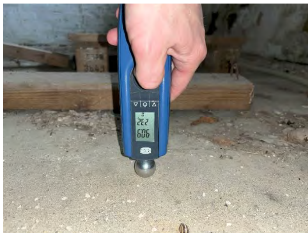
Fugtmåling af betongulv i kælder
