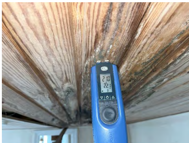
Fugtmåling af loft ved prøvested nr. 1
