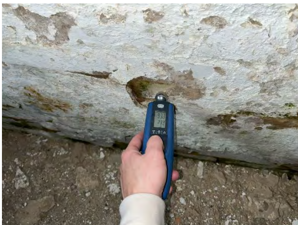
Fugtmåling af kældervæg
