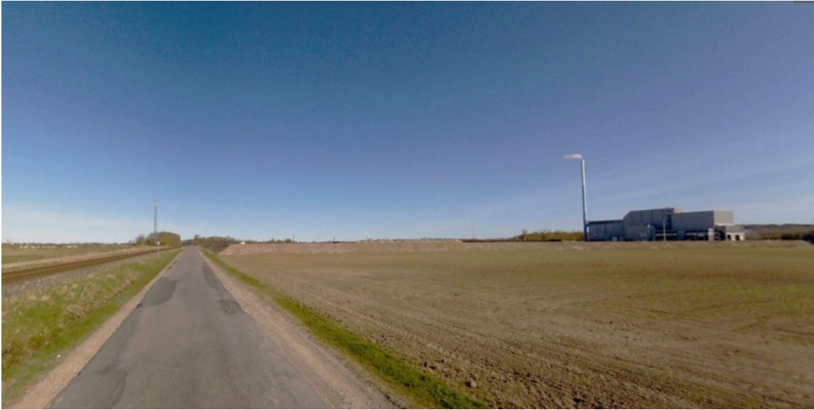
Lokalplanområdet, der er afgrænset af jordvolde, set fra Koldenåvej i sydøstlig retning. Banen forøber parallelt med Koldenåvej til venstre i billedet, mens det eksisterende forbrændingsanlæg ses til højre (COWI Gadefoto).
