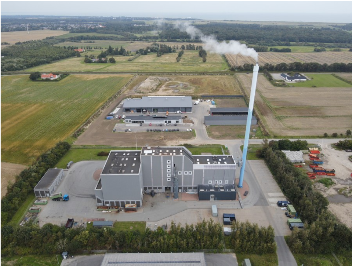
Frederikshavn Affaldskraftvarmeværk er nabo til lokalplanområdet, her set fra syd (Frederikshavn Forsyning, 2023).
