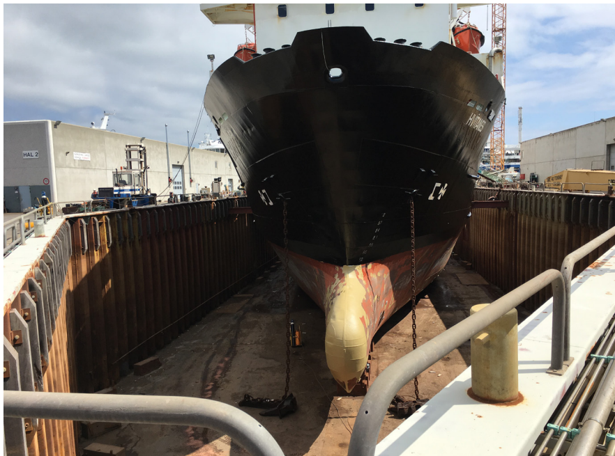
Eksisterende tørdok i brug
