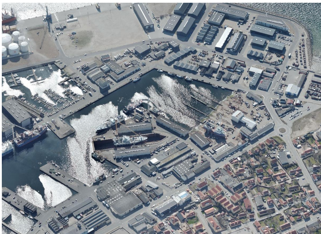
Figur 11-3. Skråfoto fra 2019. Det ses, at området omkring projektområdet er kulturhistorisk velbevaret, i form af beddingsanlæg og bygninger. 29 Siden fotoet er taget, er ét beddingsanlæg blevet fjernet.
