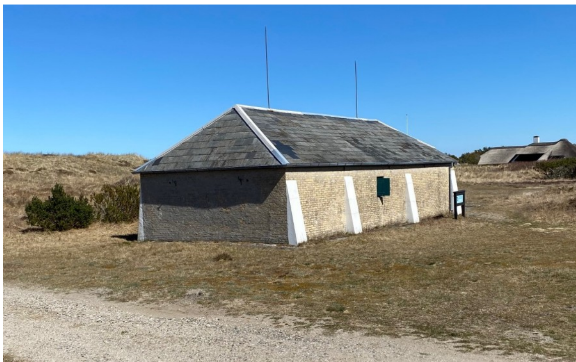
Den tidligere redningsstation fremstår original og intakt.
