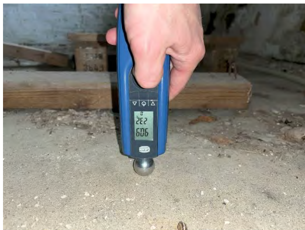
Fugtmåling af betongulv i kælder
