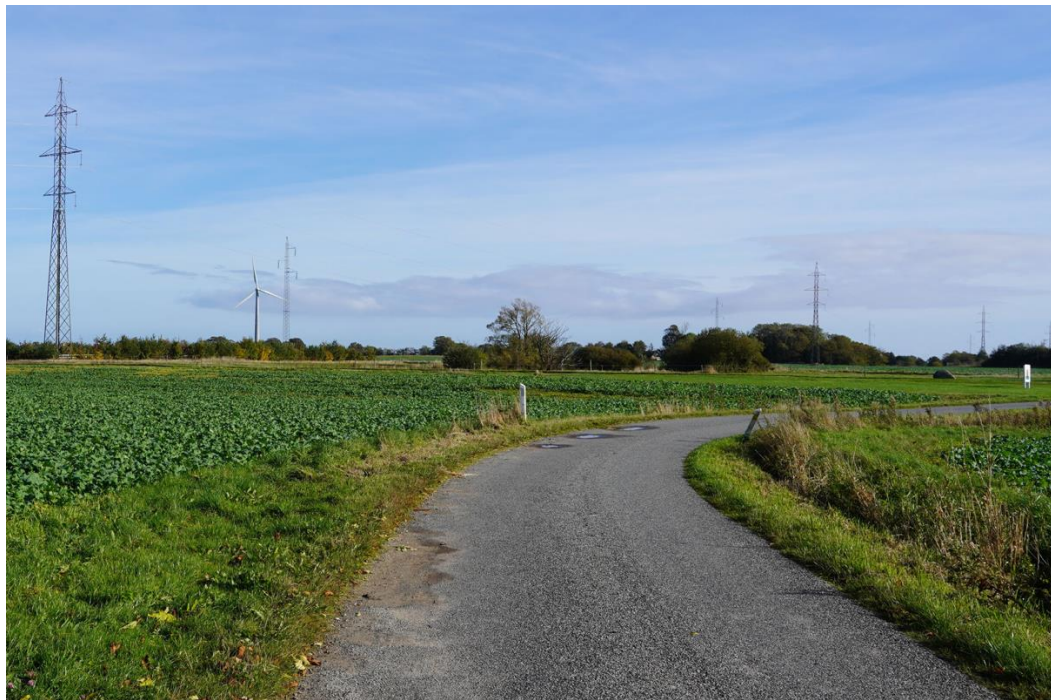
Foto 7.11: Fotostandpunkt 5 . Eksisterende forhold set fra Ribberholtvej mod nordøst
