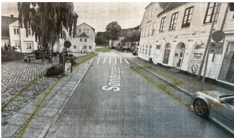
Omlægning af Søndergade nord for fodgængerfelt
